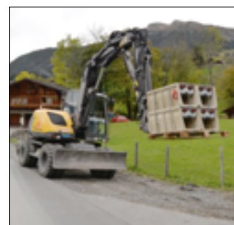
Heben mit Pallettengabel die Schweizweit ersten Strassenquerungsrollen für Ski
