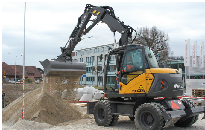
Seine Vielseitigkeit beweist der Mecalac714MWe täglich auf dem Baustellenlager.
