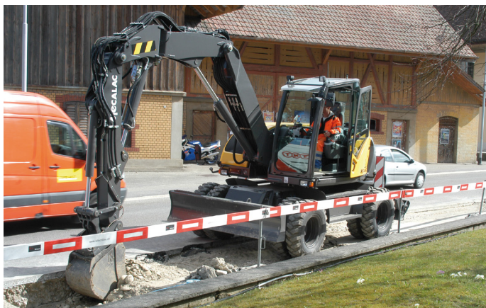
Grosse Sicherheit bei Baggerarbeiten dank Kurzheck und kleinem Wendekreis.
