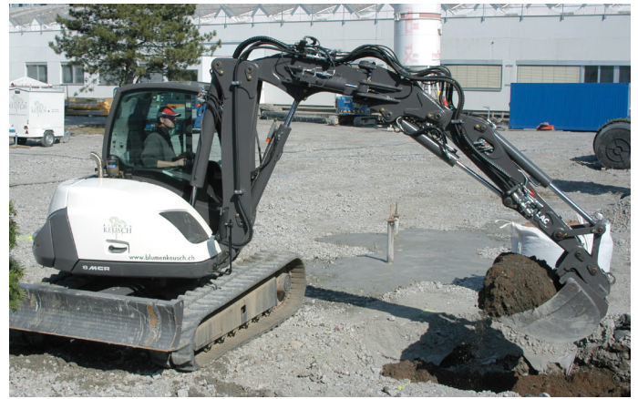
Mit dem Mecalac 8MCR können Baggerarbeiten bis zu einer Grabtiefe von 3.70 m ausgeführt werden.
