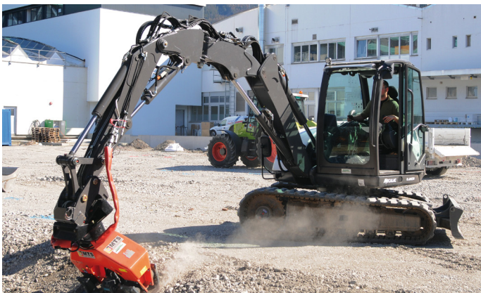
Der Mecalac 8MCR ist äusserst vielseitig: Bodenverdichtung mit der Vibroplatte.
