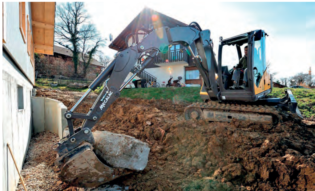
Quadersteine setzen mit bis zu 3 Tonnen Hubkraft kein Problem
