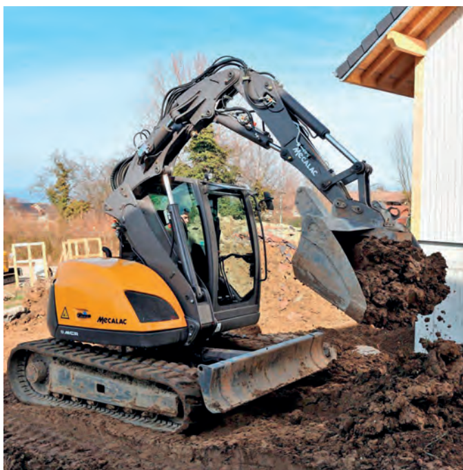
Humus auftragen mit der Skid-Schaufel
