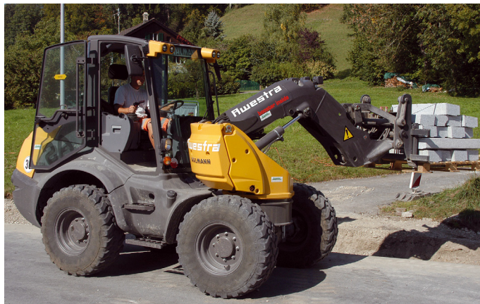
Eine Routinarbeit für den AS 900: Das seitliche Absetzen von Bordsteinen.
