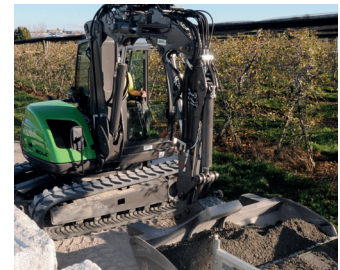
Der Beton wird vom Kipphanhänger direkt in die Skidschaufel des Mecalac 8MCR geleert. Ein Huki-Einsatz erübrigt sich.
