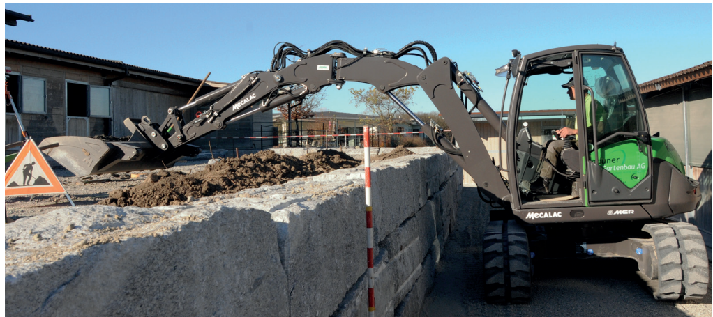
In einem Arbeitsgang kann der Mecalac 8MCR mit der Skidschaufel den Beton ab Lastwagen direkt in die Pfahllöcher verteilen.
