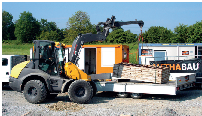
Mecalac AS 900 – der Alleskönner in der Baustellenlogistik.
