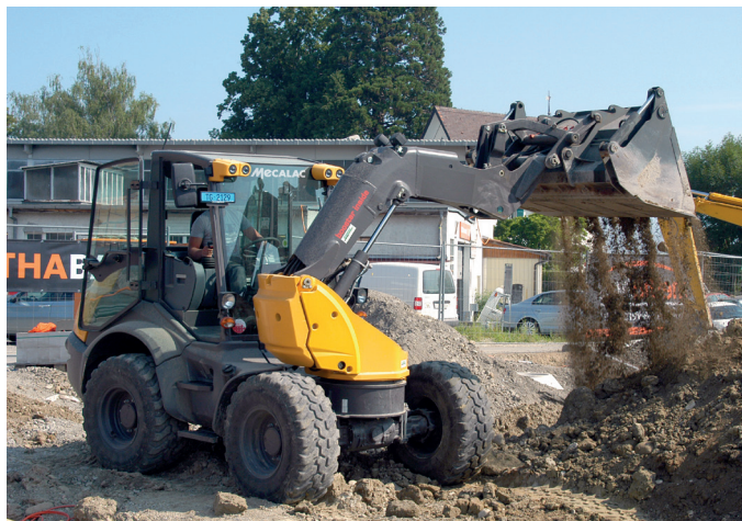
Auch bei Erdbewegungsarbeiten fühlt sich der AS 900 so richtig im Element.
