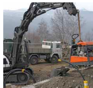
Der Mecalac 8MCR beweist auf jeder Baustelle seine Vielseitigkeit.
