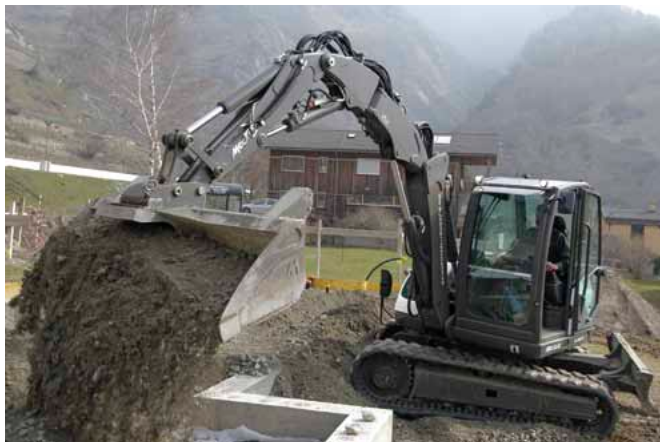
Der Mecalac 8MCR im Einsatz bei Planierungsarbeiten mit der Skidschaufel.
