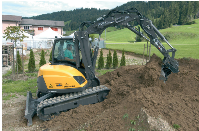
Bei Planierungsarbeiten ist der Mecalac 8MCR so richtig in seinem Element.
