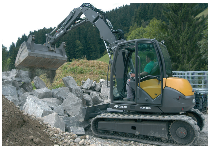
Auf der Baustelle kann der Mecalac 8MCR äusserst vielseitig eingesetzt werden.
