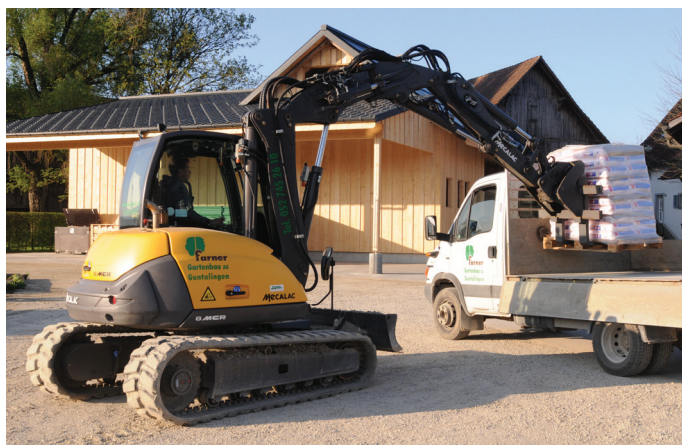
Der Mecalac 8MCR erledigt alle gängigen Arbeiten eines Laders, Baggers und Staplers. Hier beim Entladen des Firmenfahrzeuges.
