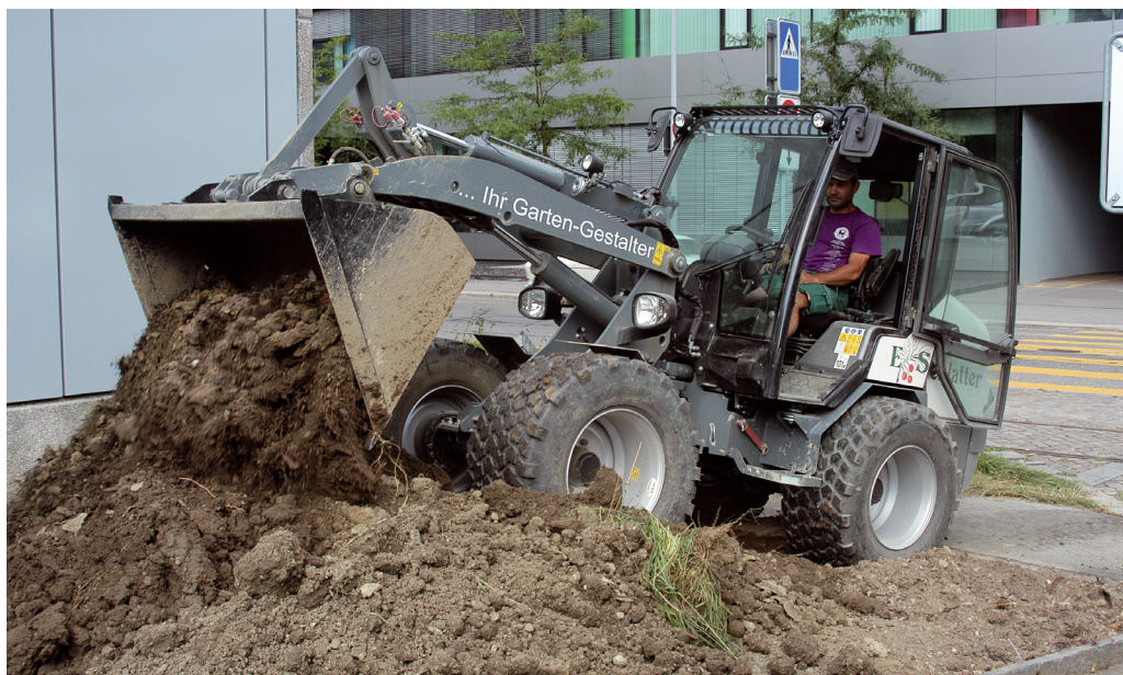
Bei Erdbewegungsarbeiten kann der Giant V6004T X-tra seine grosse Kraft und Standfestigkeit so richtig einsetzen.
